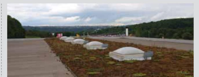
**La cubierta de la central de Crown en Stuttgart, Alemania,** tiene 1637 metros cuadrados y está revestida de vegetación. Al añadir una amplia cubierta verde sobre el edificio, Crown es capaz de mejorar el microclima y reducir la factura energética.
