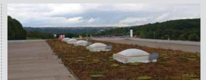
Le « toit vert » de la succursale allemande de **Crown Stuttgart** mesure 1 637 m<sup>2</sup> et est recouvert de végétation. L'ajout de ce gigantesque toit vert au-dessus des bureaux a permis à Crown d'améliorer le microclimat et de réduire les coûts énergétiques.
