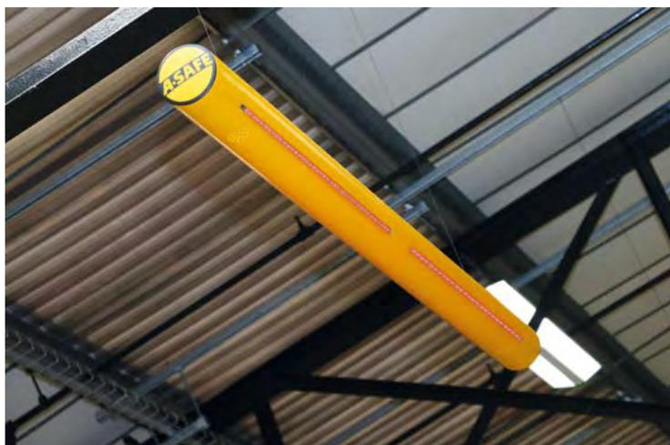
Conçu pour protéger les produits en hauteur contre les dommages accidentels causés par les chariots en mouvement.
