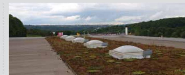
**Зеленая крыша подразделения компании Crown в Штутгарте, Германия,** установлена на площади в 1637 кв. метров и покрыта насаждениями. Установка такой же зеленой крыши на офисном здании позволит компании Crown улучшить микроклимат и сократить расходы на электроэнергию.
